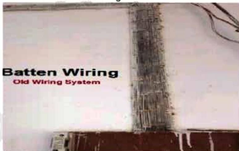
(Fig.5.3. Batten Wiring)
